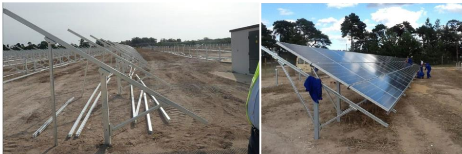
Montaža solarnih panela na zemlji
