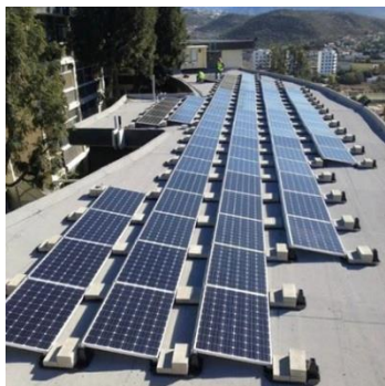
Balastna solarna ugradna konstrukcija za ravni krov
