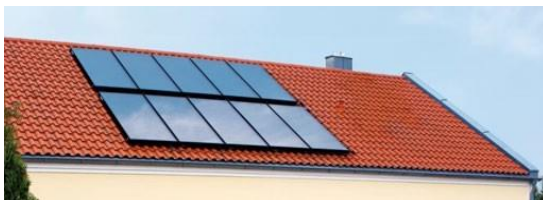
Ravni pločasti kolektori postavljeni na krovu stambenog objekta
