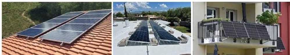
Solarni paneli na krovovima stambenih objekata
