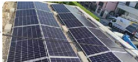
Montaža panela na ravnom krovu
