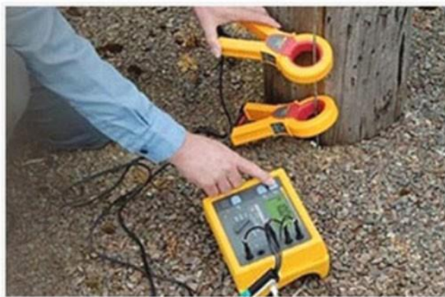
Testiranje gromobranske instalacije
