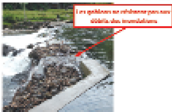
Exemples de matériaux à éviter pour les barrages
