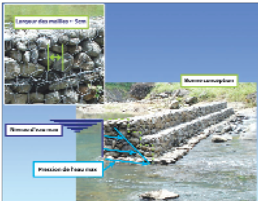
Gabion utilisé pour construction de barrage
