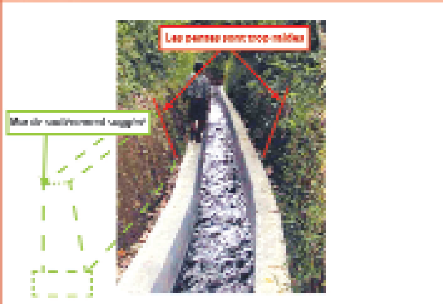
Canal d'aménage dans une coupe transversale profonde et raide
