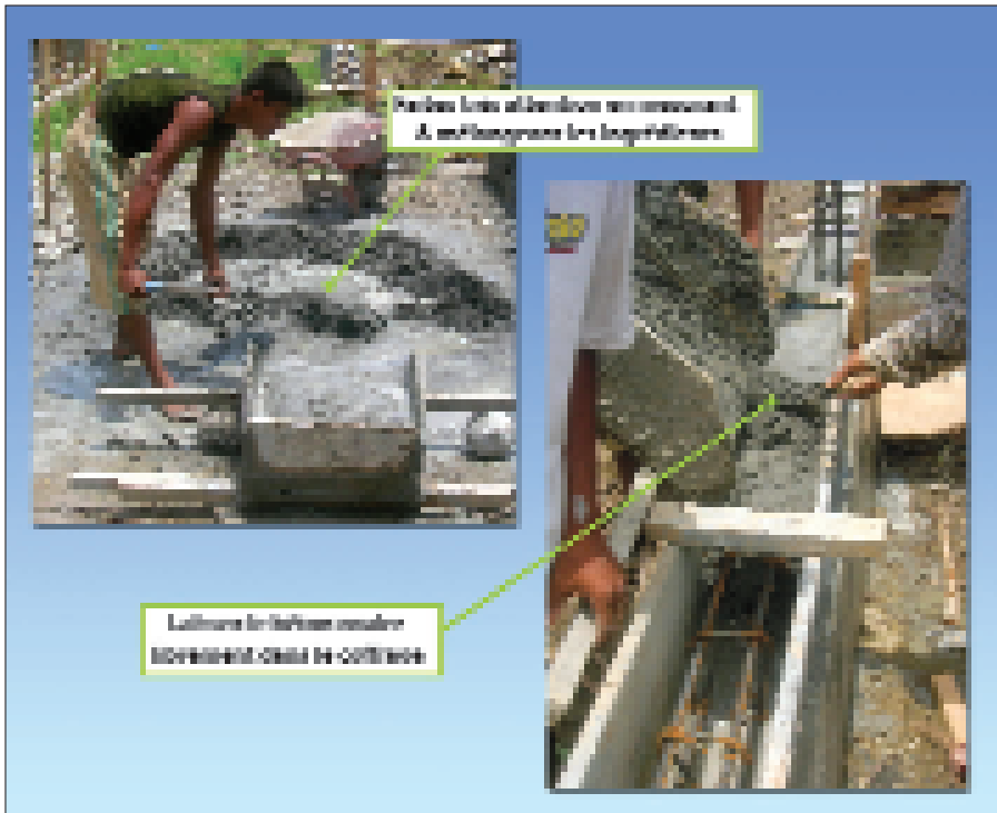
Construction d'un bloc d'ancrage
