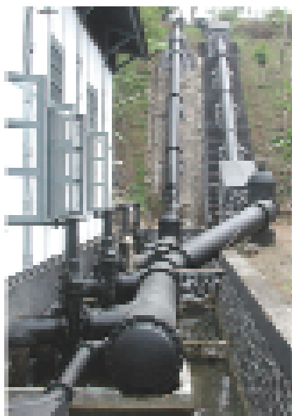
Quelques bons exemples de supports de conduite forcée
