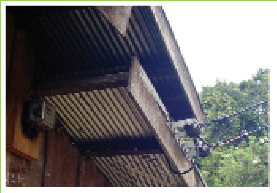
Branchement de maison - bon
