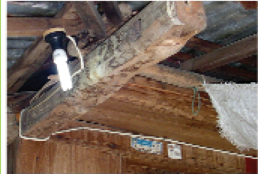
Installations de lampes - bon
