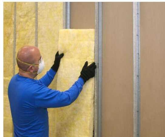
Imágenes 14/15: Fibras minerales instalados dentro de un calibre estructural
