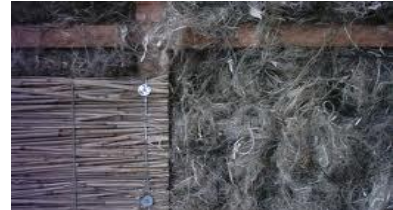
Fibra de cáñamo para aislar, con estera de paja para fijar
