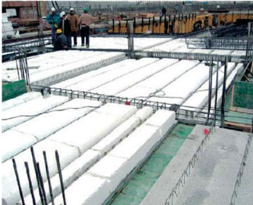
Imagen 16: Sistema de bovedillas con EPS
