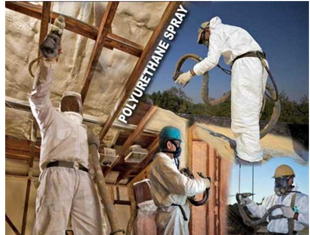
Aplicación de espuma como aislante (SPUR)
