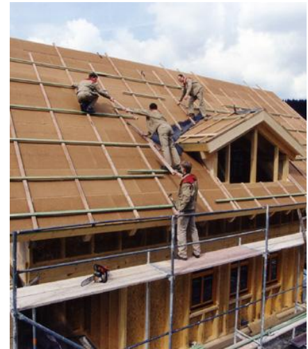
Imagen 22: Falso techo de tablas de fibra de madera, encima se meterán tejas
