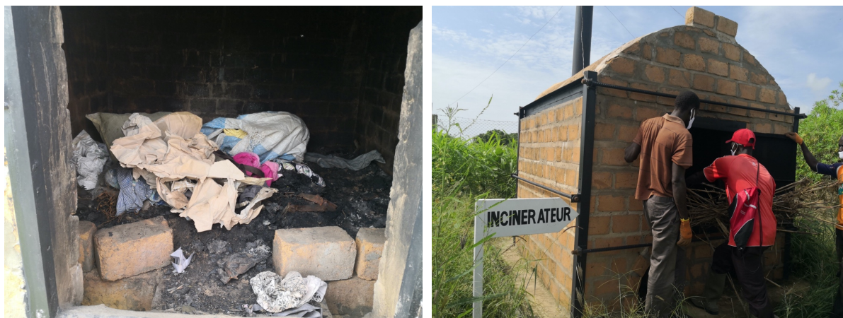
Image 5 : Système de brûlage des déchets
