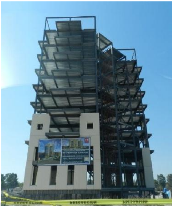
Imagen 12: Instalación de fachadas prefabricadas en un edificio de departamentos en Juriquilla, Querétaro, Qro.
