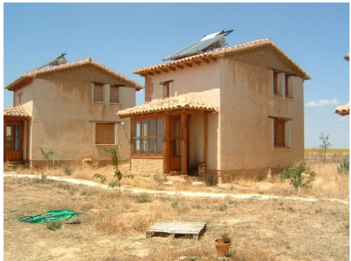
Imagen 5: Vivienda de adobe
