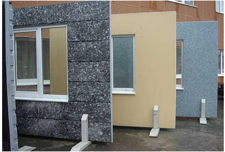
Imagen 11: Módulos prefabricados de fachadas
