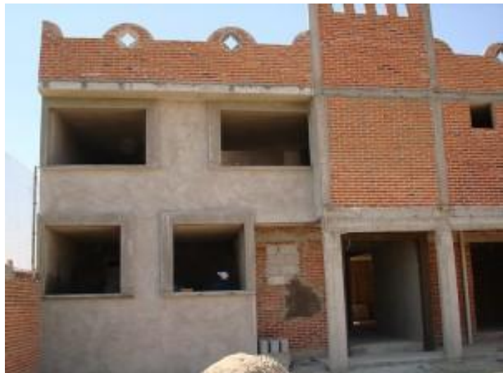
Imagen 6: Vivienda en proceso de revoque
