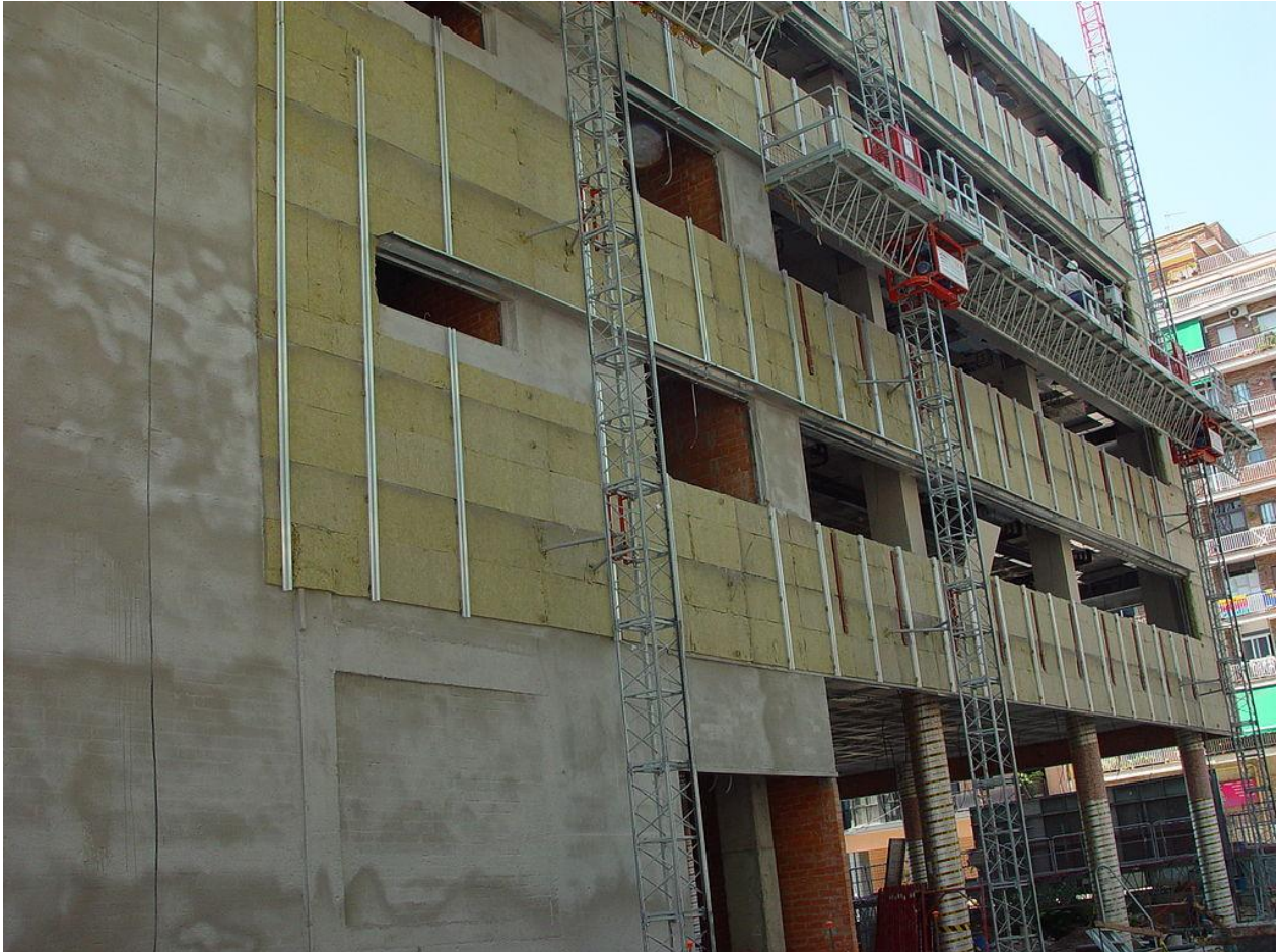
Imagen 2: Instalación de lana mineral en una fachada ventilada
