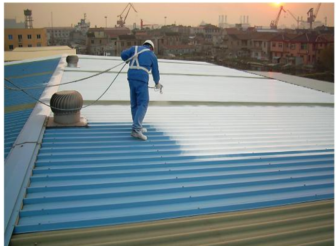
Imagen 7: Aplicación de superficie reflejante
