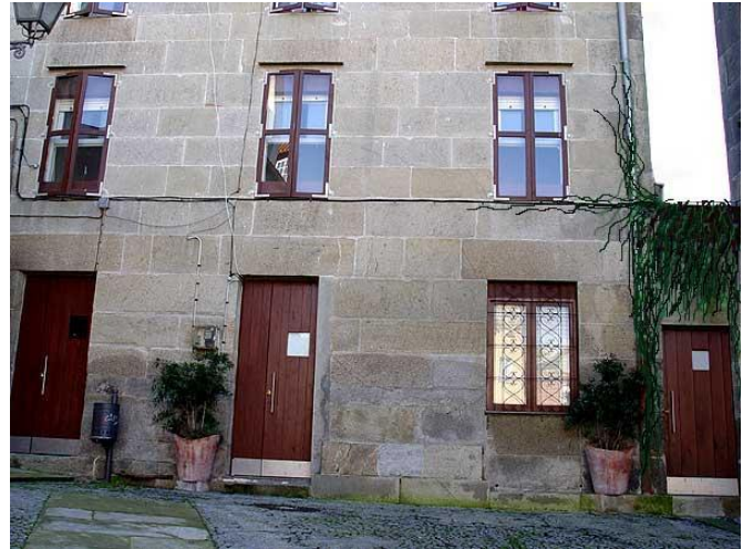
Imagen 9: Ejemplo de una fachada pesada
