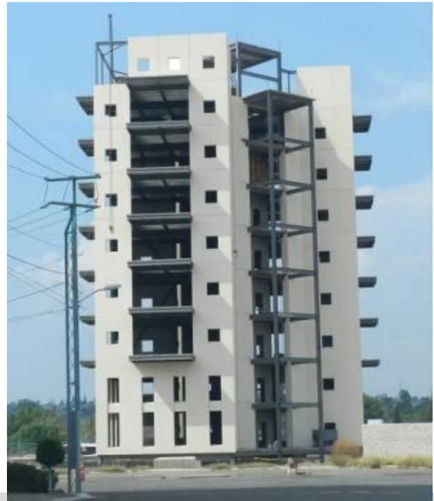
Imagen 12: Instalación de fachadas prefabricadas en un edificio de departamentos en Juriquilla, Querétaro, Qro.
