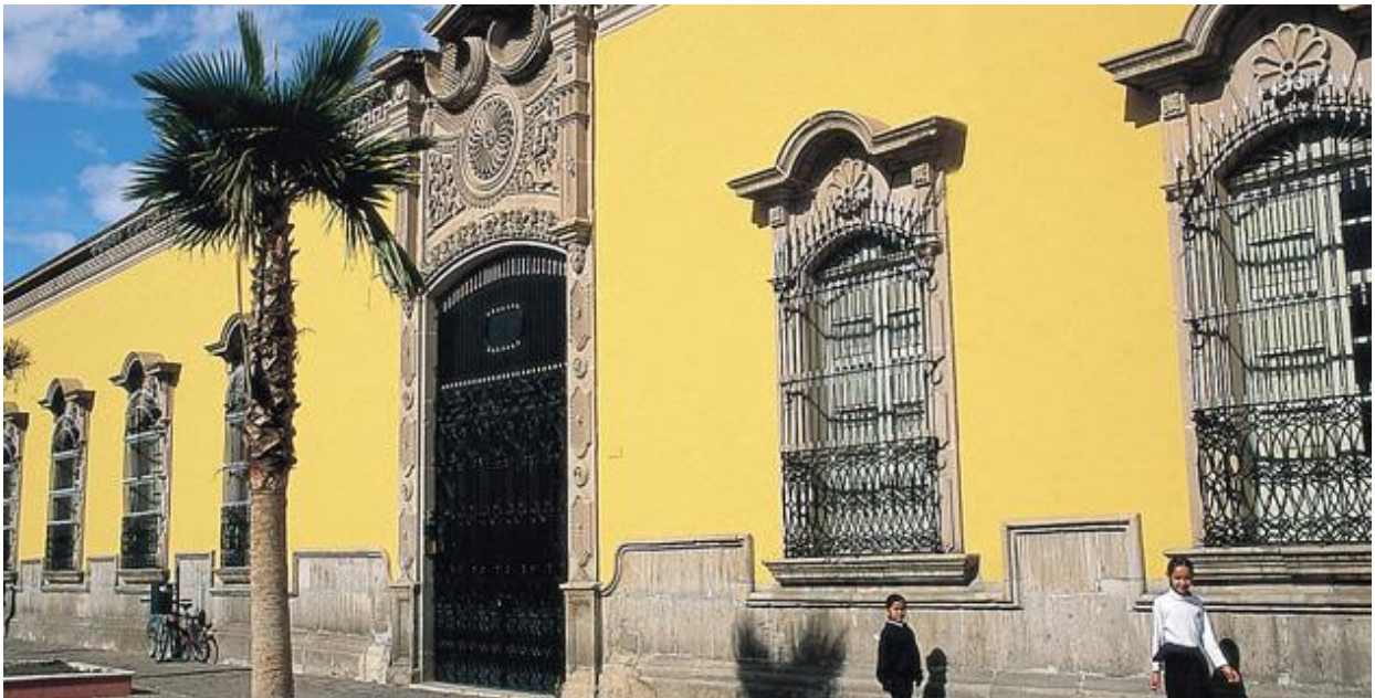
Imagen 10: Fachada pesada del Arzobispado de Durango, Dgo.
