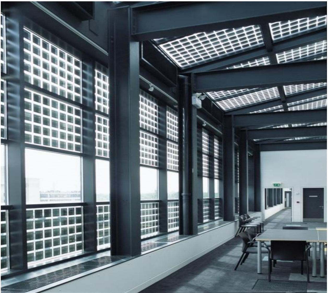
Imagen 16: Celdas fotovoltaicas integradas a la fachada de un edificio
