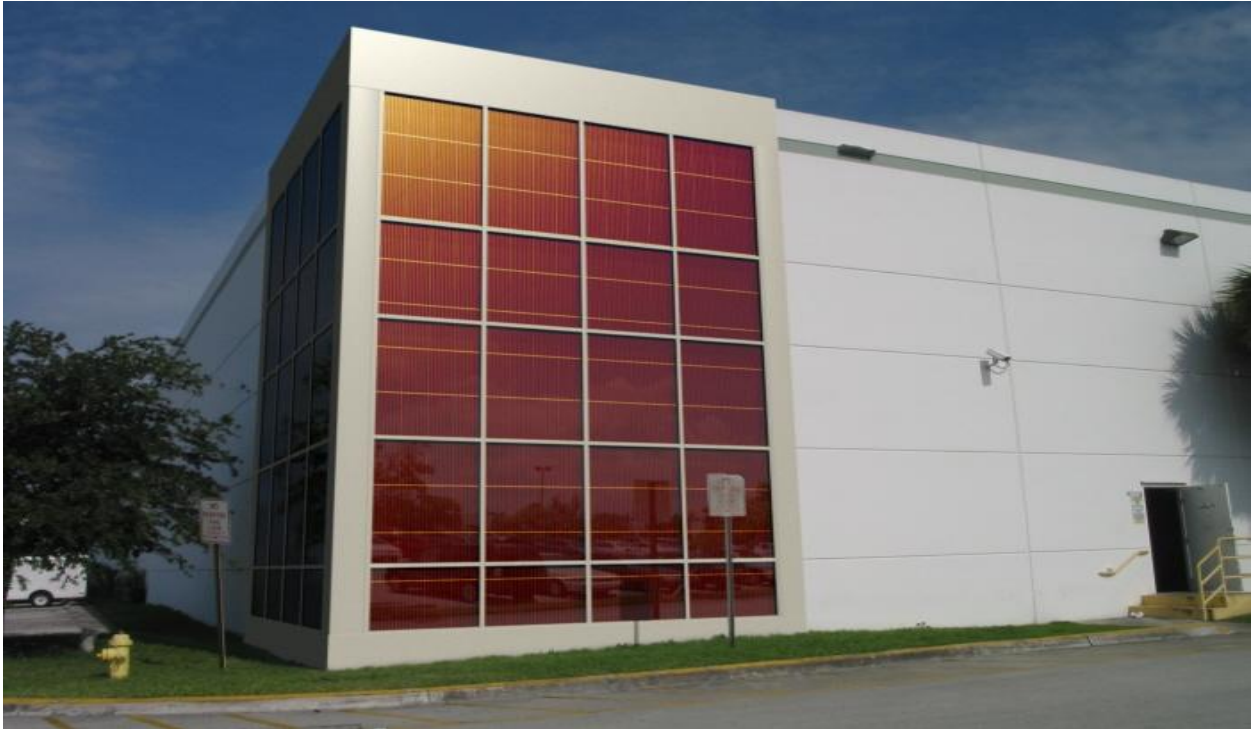
Imagen 14: Fachada en un edificio que convierte la luz solar en energía eléctrica
