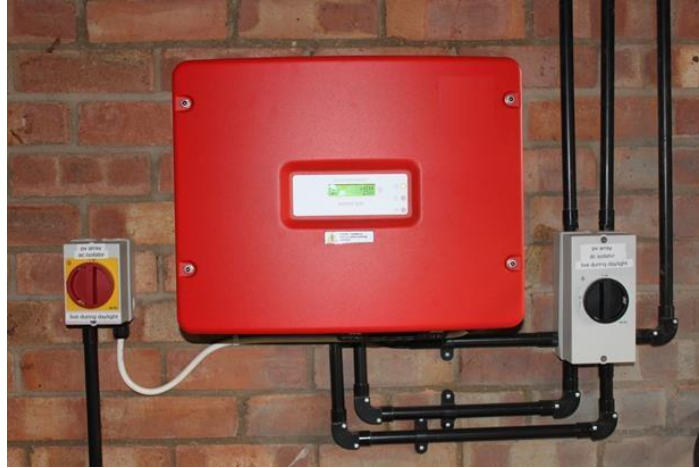
Ilustración 8: Típico montaje de un inversor
