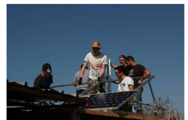
Studenten beim Aufbau der Pilotanlage in Marokko
