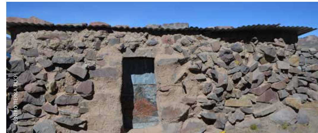
Las investigaciones buscan mejorar las condiciones arquitectónicas de las viviendas en zonas rurales andinas.
