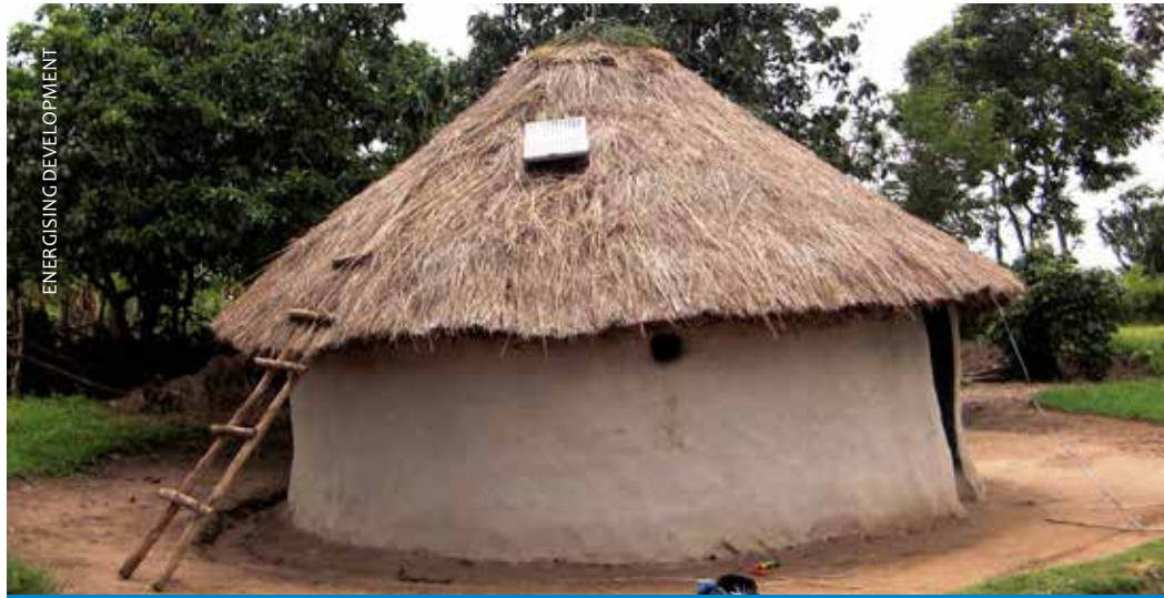
Una vivienda rural en Mozambique cuenta con un sistema fotovoltaico doméstico.
