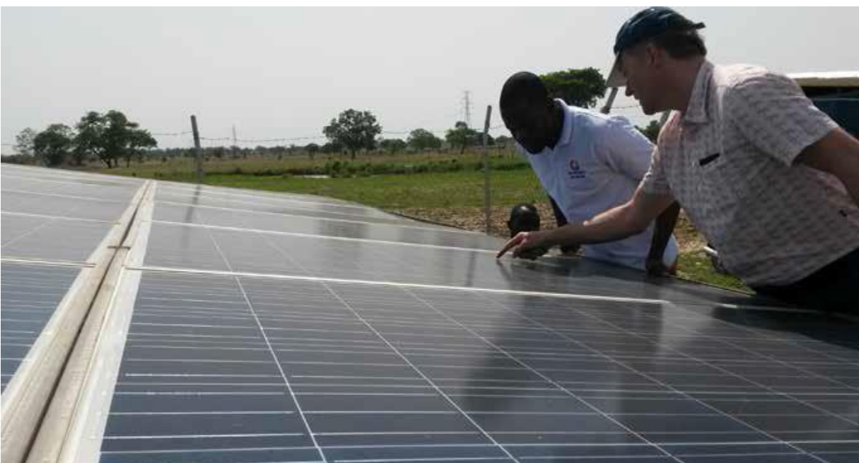
Contrôle visuel des panneaux solaires
