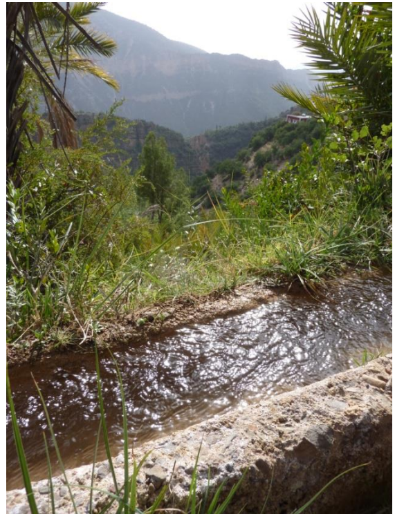
Canal d'irrigation en béton
