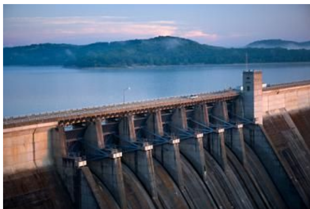
Figura 12: Presa, ejemplo del uso de la energía hidráulica
