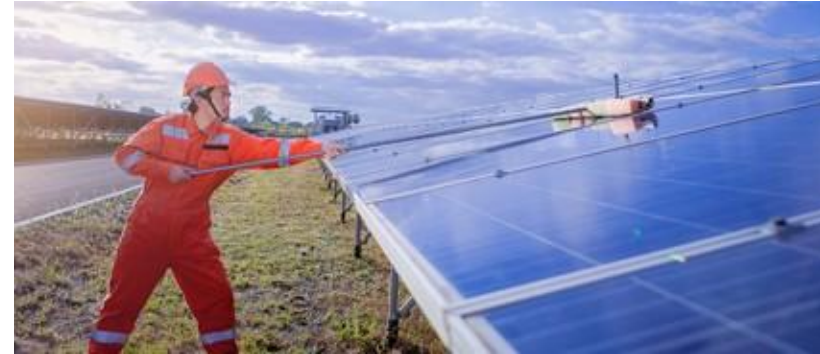
Lavado de paneles
