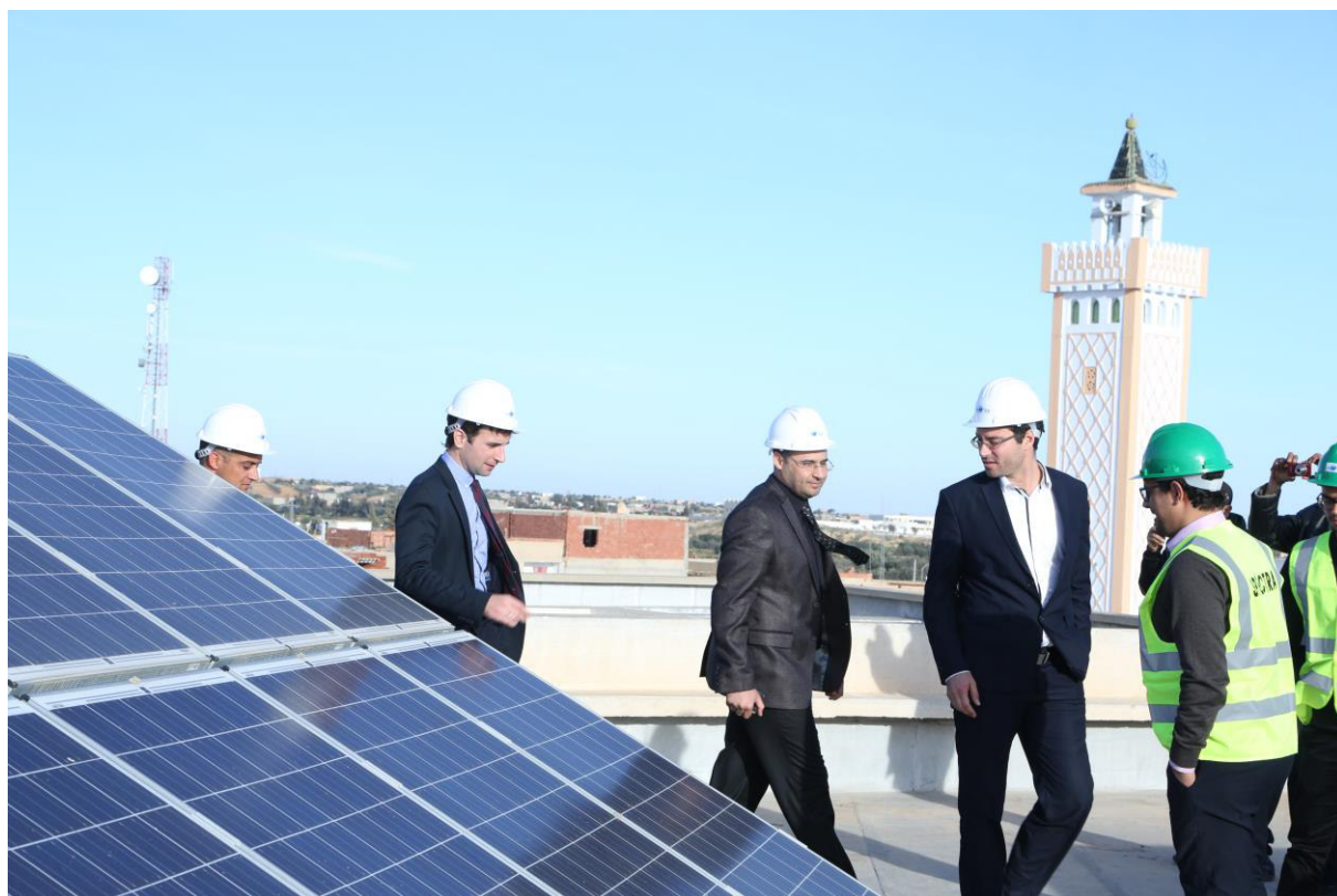
Visite de la centrale photovoltaïque sur le toit de l'ANME par un groupe de professionnels.
