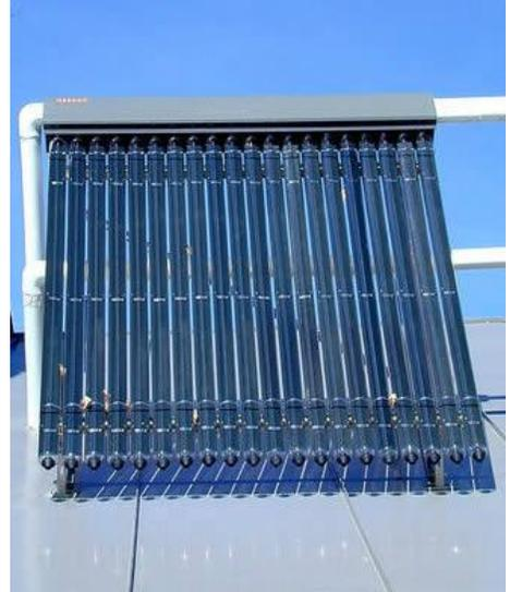
**Imagen 17: Colector Solar de Tubos Evacuados**
