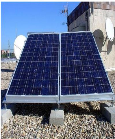
**Imagen 10: Módulo Fotovoltaico de celdas monocristalino**
