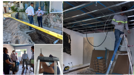
Foto: Construcción del nuevo laboratorio del Centro Regional de Semillas Forestales. Archivo GIZ.
