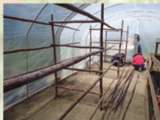
CONSTRUYENDO LAS TARIMAS
