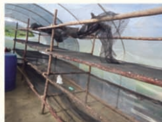
PUESTA Y TENSADO DE LA MALLA ANCHOVETERA
