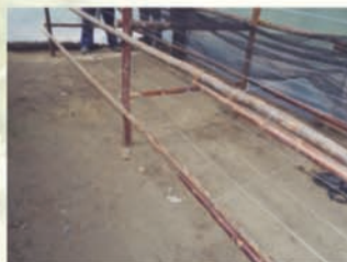
PUESTA Y TENSADO DEL ALAMBRE GALVANIZADO
