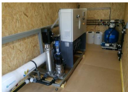
Photo de gauche : < Le chantier de l'unité de Gandiaye >
