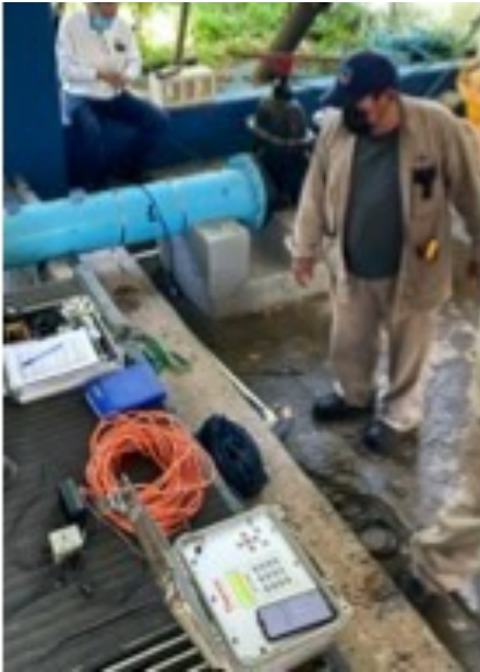
Foto 7. Medición de caudal en cárcamo San Sebastián, JAPAY
