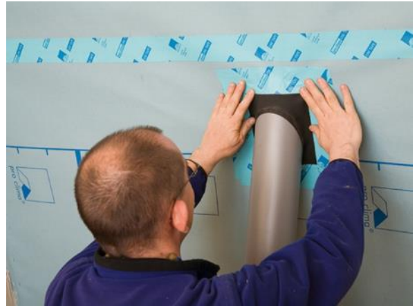
Imagen 48: Sellado hermético de las penetraciones de las instalaciones
