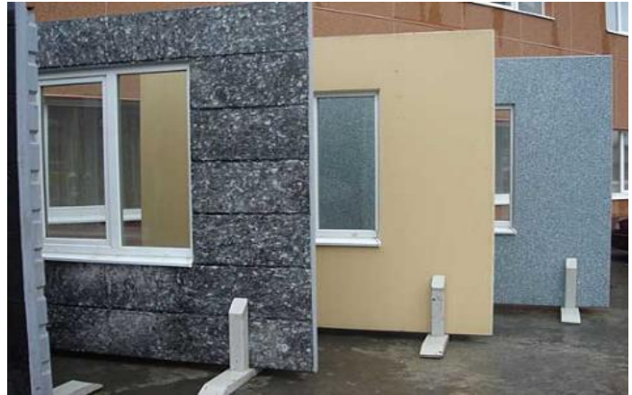
Imagen 38: Módulos prefabricados para fachada
