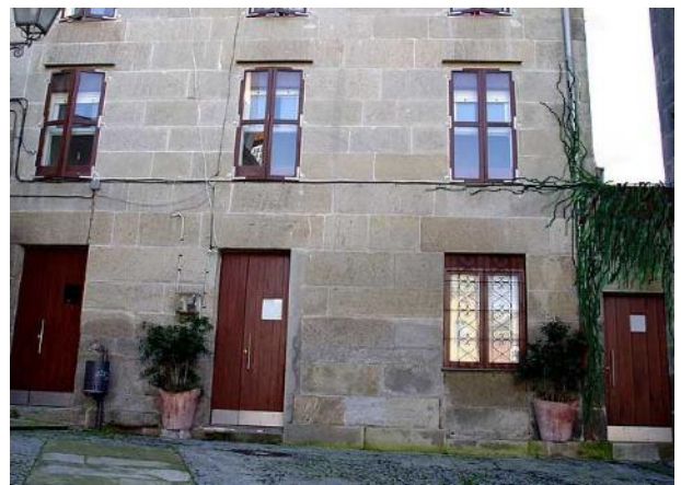
Imagen 35: Ejemplo de una fachada pesada
