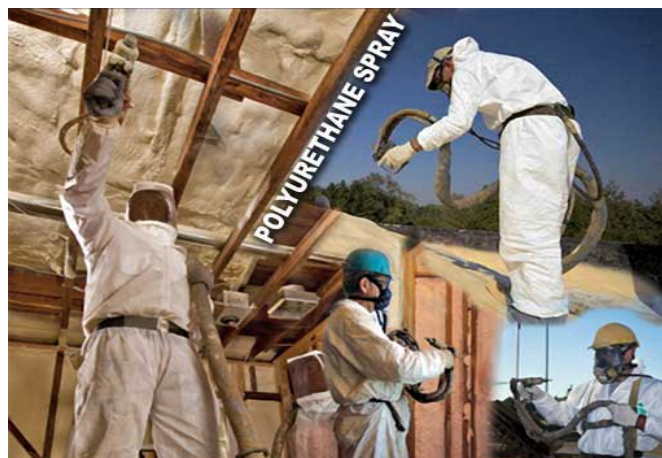
Imagen 56: Aplicación de espuma como aislante (SPUR)
