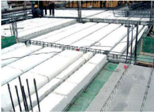
Imagen 54: Sistema de bovedillas con EPS
