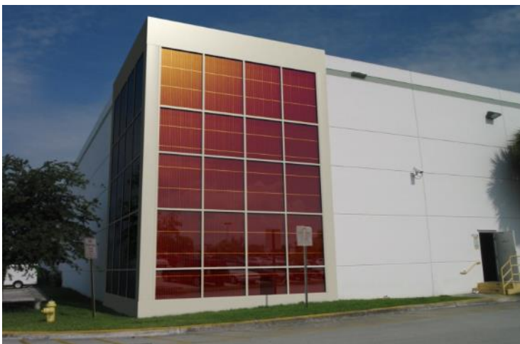
Imagen 40: Fachada de un edificio que convierte la luz solar en energía eléctrica
