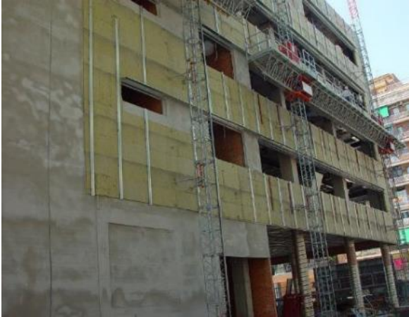
Imagen 39: Instalación de lana mineral en una fachada ventilada
