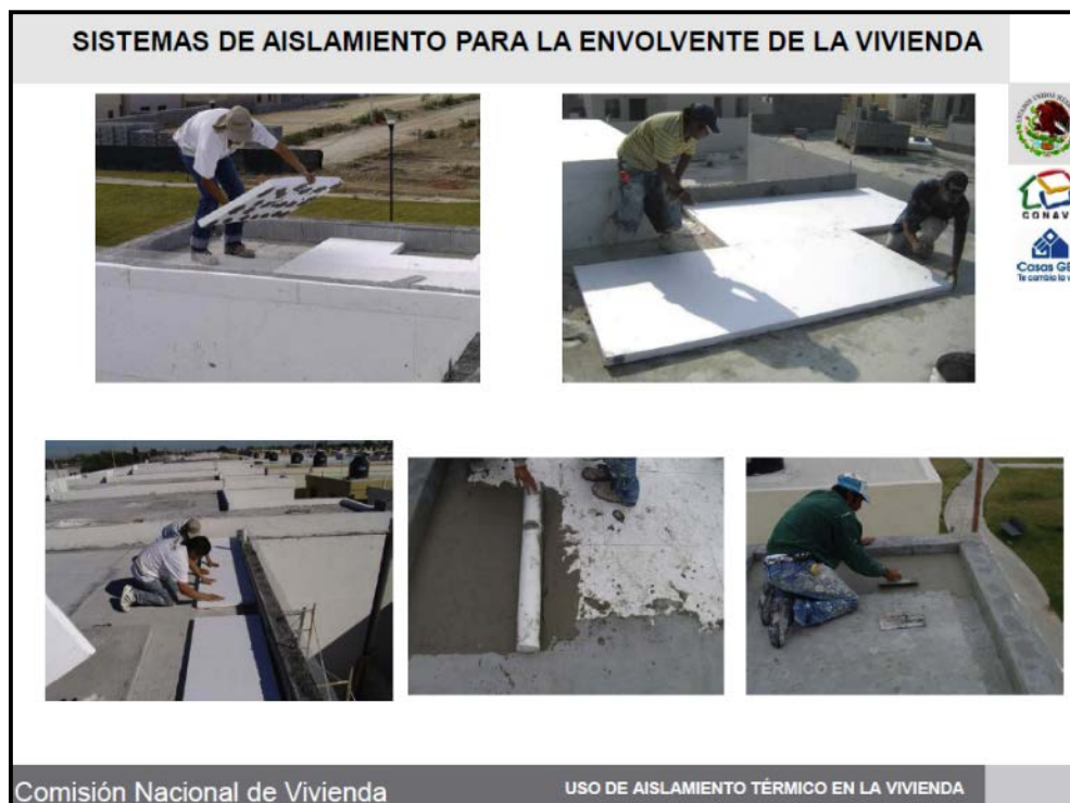
Imagen 55: Aplicación de aislantes en la construcción de viviendas GEO
