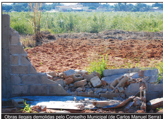
Obras ilegais demolidas pelo Conselho Municipal (de Carlos Manuel Serra)
