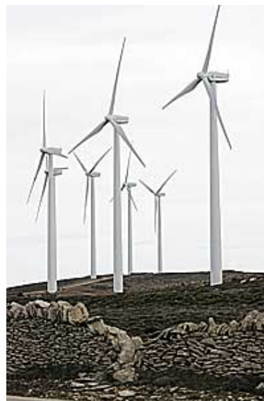
Fotografía 1. España, parque eólico
