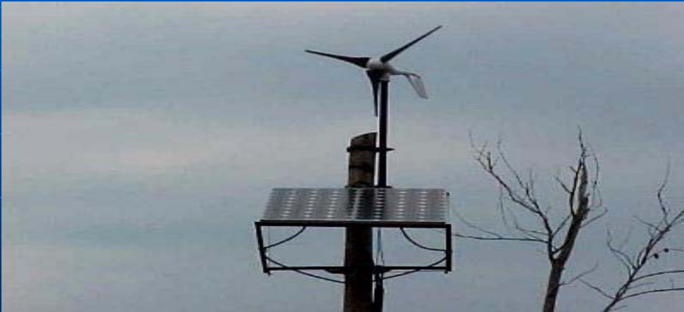
Figura 1. Sistema híbrido (solar e eólica) de geração de energia eléctrica Fonte: www.landmark-halle.de
