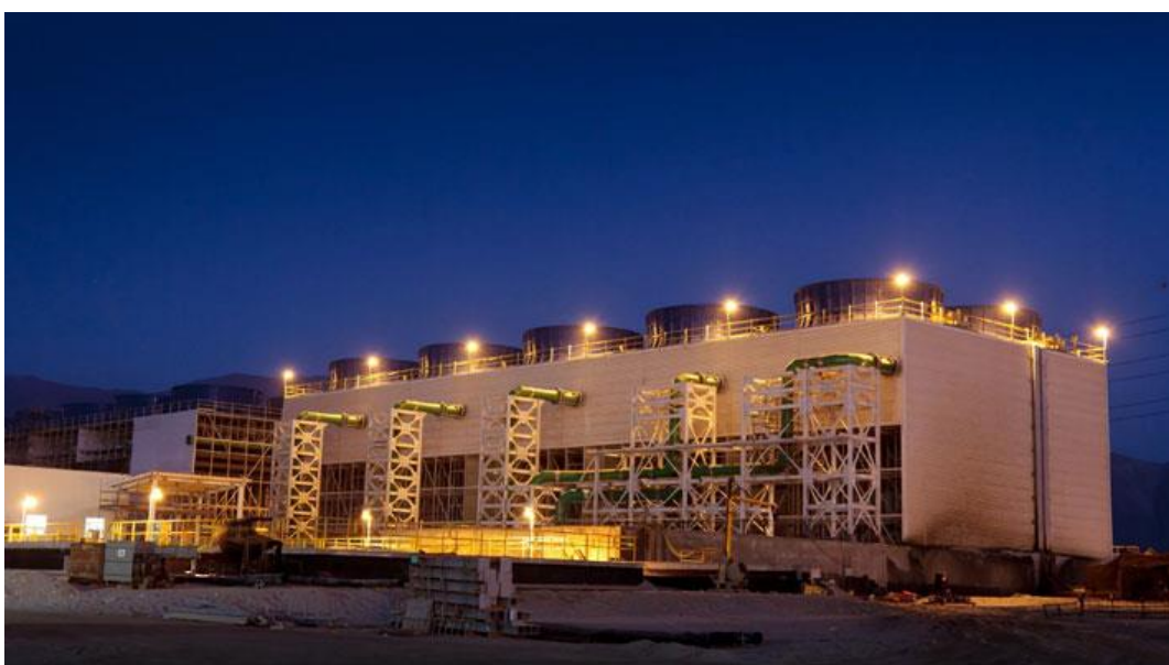
Foto: Central Termoeléctrica Angamos, al norte de Chile. Gentileza de AES Andes.
