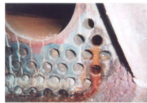
Percement tubes de fumées
