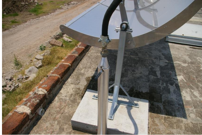
Figura 5: Ejemplo de una buena instalación – Aislante en tubería de agua caliente
