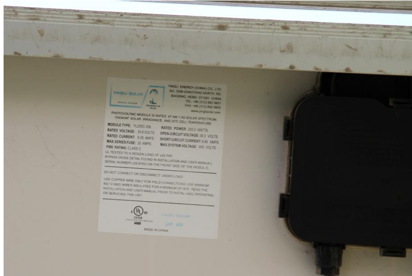
Figura 16: Ejemplo de buena calidad en los equipos – Panel con certificado visible
