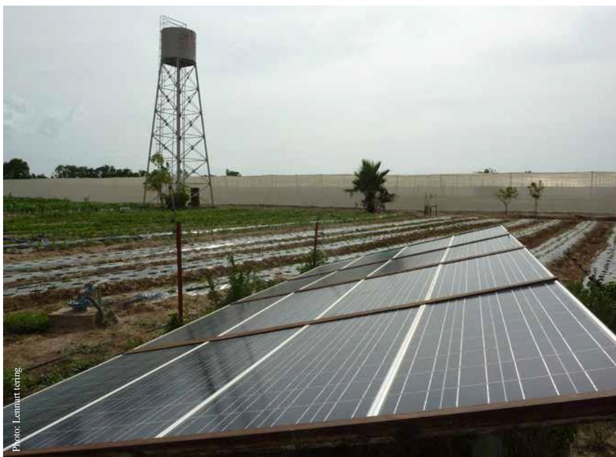
SPIS provisto de un reservorio elevado, utilizado para riego dentro y fuera del invernadero
