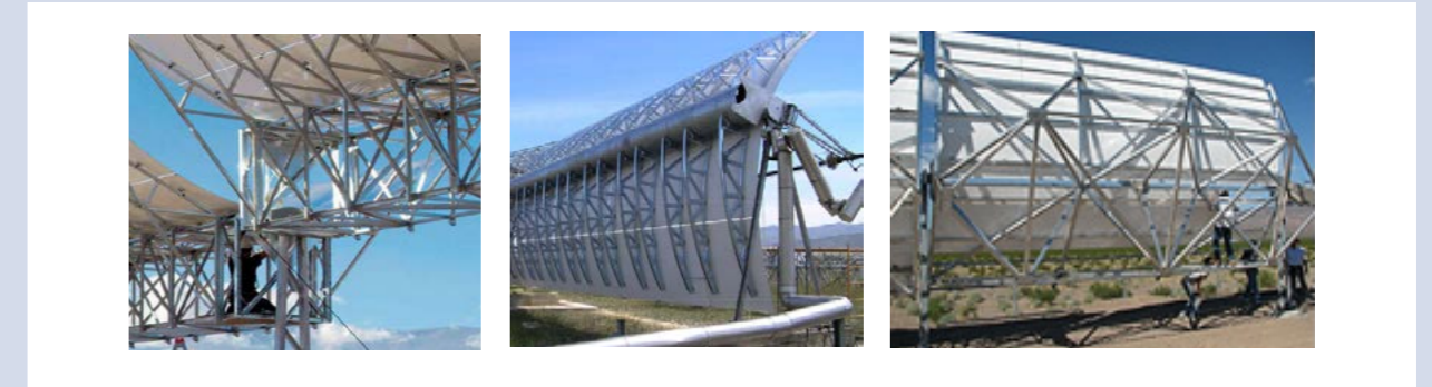
Figure 29 : Formes de capteurs cylindro-paraboliques : boîte torque (gauche), boîte torque à bras cantilever (centre), supports et plateformes terrestres.
