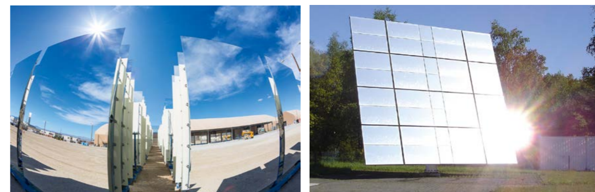
Figure 43 : Miroirs d'héliostats avec une surface de jusqu'à 120 m 2
