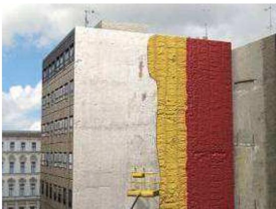
Figure 33 : isolation extérieure par PUR projeté (<http://www.maroc.prix-construction.info>)
