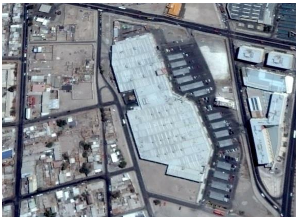
Ilustración 1: Foto aérea Complejo Comercial Portal Calama. Fuente: Google Earth
