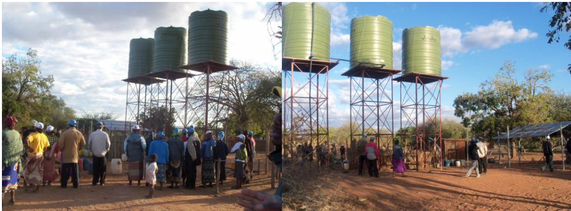
Figura 2: Os participantes observam um sistema de bombeamento de água fotovoltaico.
