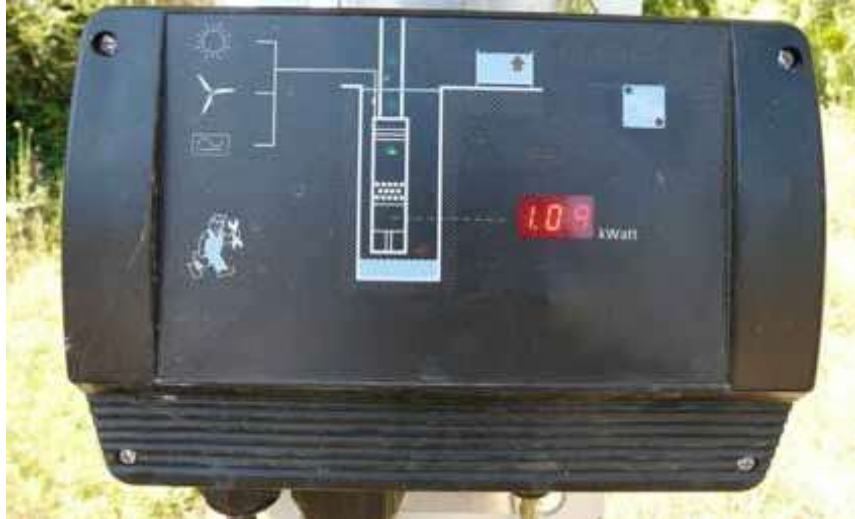
جهاز التحكم مع شاشة عرض ومؤشر LED للخلل
