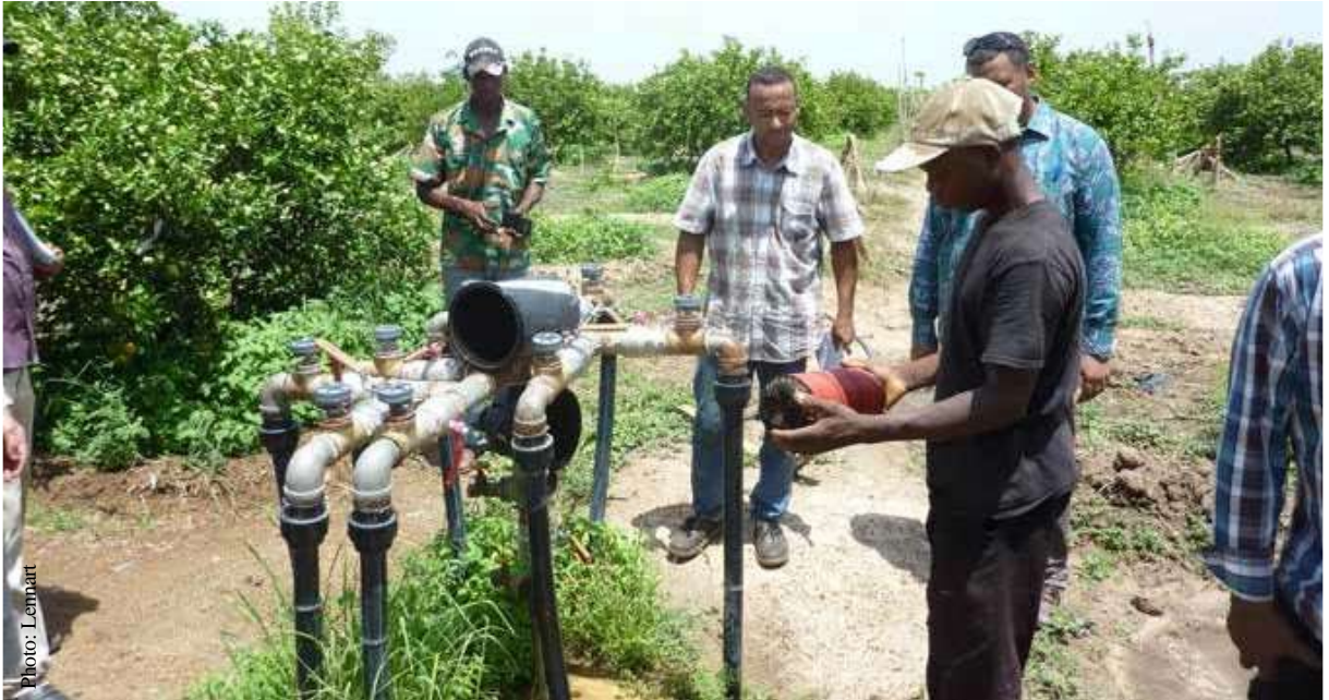
وحدة التحكم في الريّ مزود بمرشح (فلتر) قرصي وصمامات (محابس) متعددة لتوجيه المياه إلى أجزاء مختلفة من نظام الريّ
