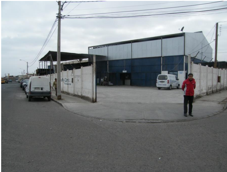
Ilustración 18: Lugar de instalación del generador solar
