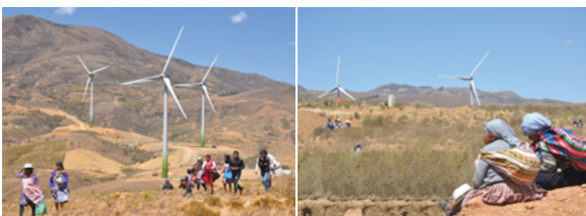
Parque eólico Qollpana (Cochabamba - Bolivia)
