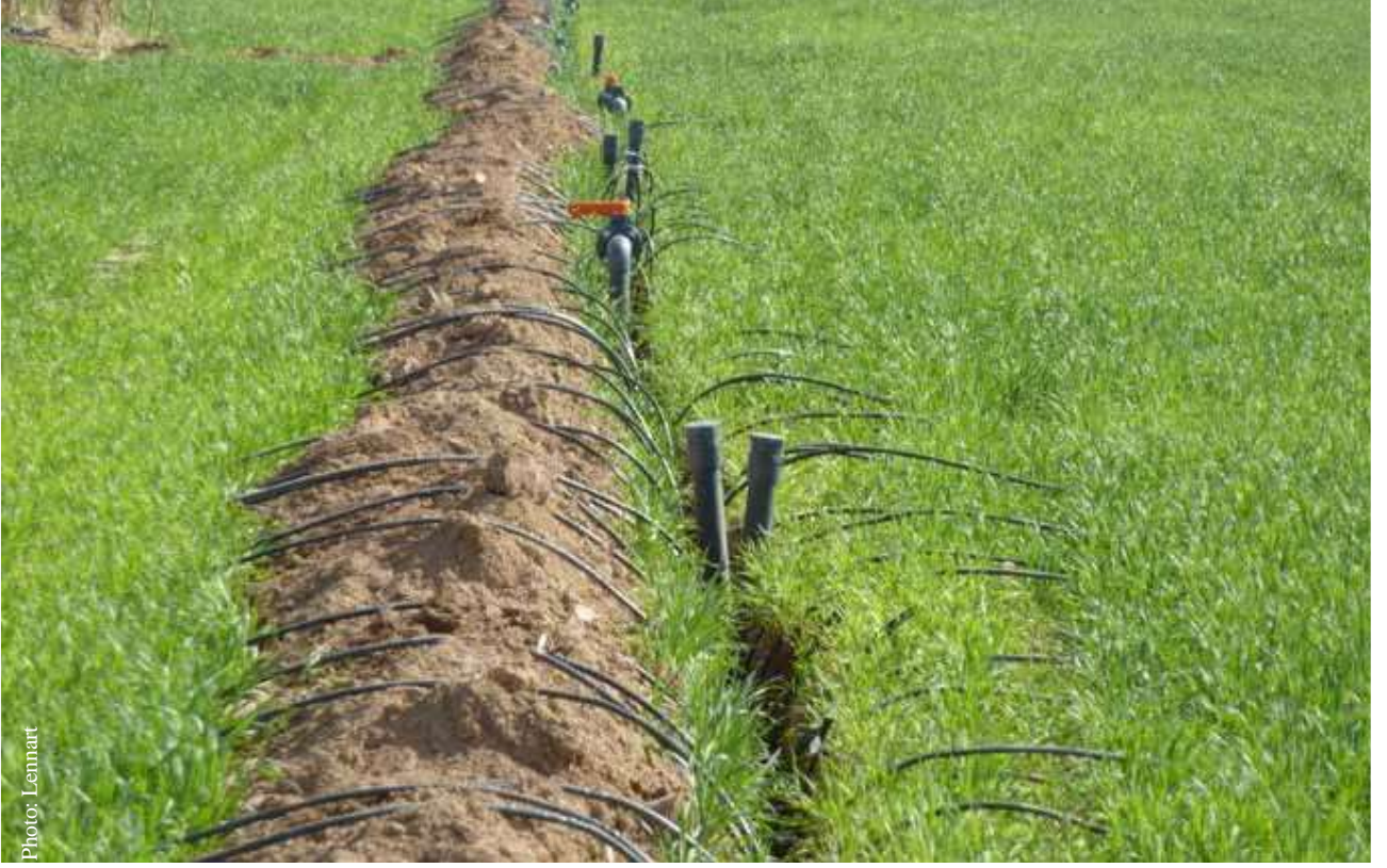
تركيب نظام الري بالتنقيط (المصدر: Lennart Woltering)
