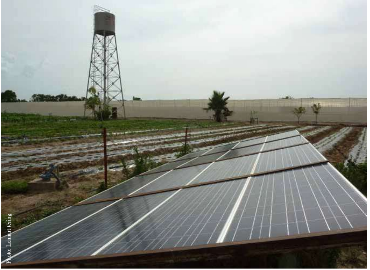
نظام SPIS مع خزان علوي (مرتفع) يُستخدم للريّ داخل وخارج الدفيئة (المستنبت الزجاجي) (المصدر: Lennart Woltering)
