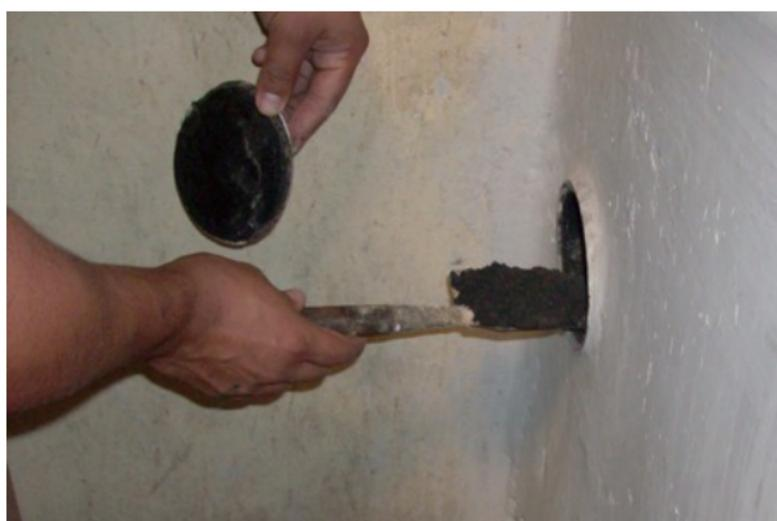
Limpiar el hollín de la parte inferior de la plancha metálica que tiene contacto con la llama (sin utilizar agua).
