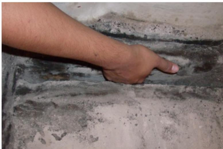
Se dan suaves golpes a la chimenea para que se desprenda el hollín que se ha adherido a las paredes internas de la chimenea.
