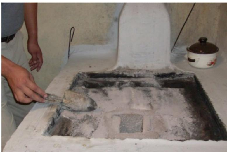
Limpiar el conducto interno que separa la ceniza de la chimenea, removiendo el hollín acumulado.
