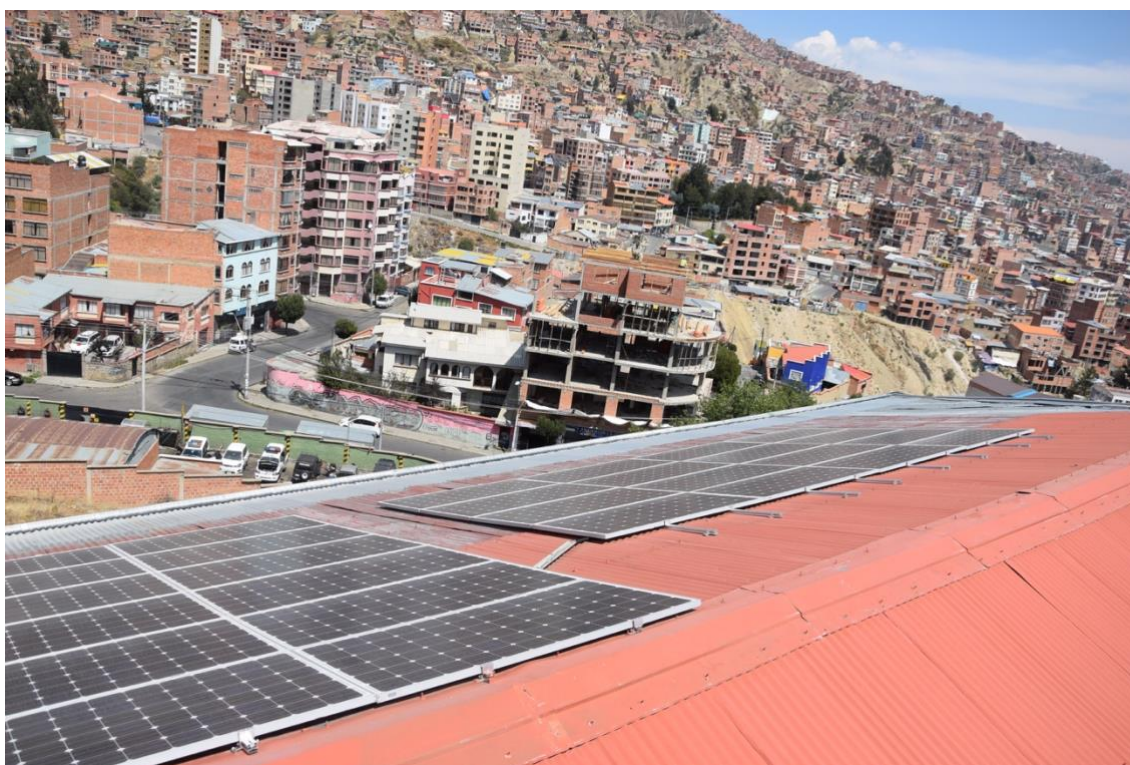
Foto: Paneles solares, Hospital Arco Iris, La Paz -Bolivia. Archivo GIZ
