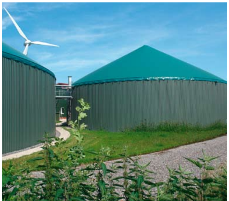
Gehlenberg biogas plant
