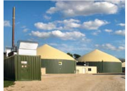
Biogas plant Fond du Lac, U.S.A.
