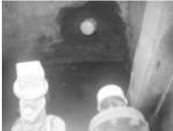
Figura 30. Trabajos de aislamiento de sectores
