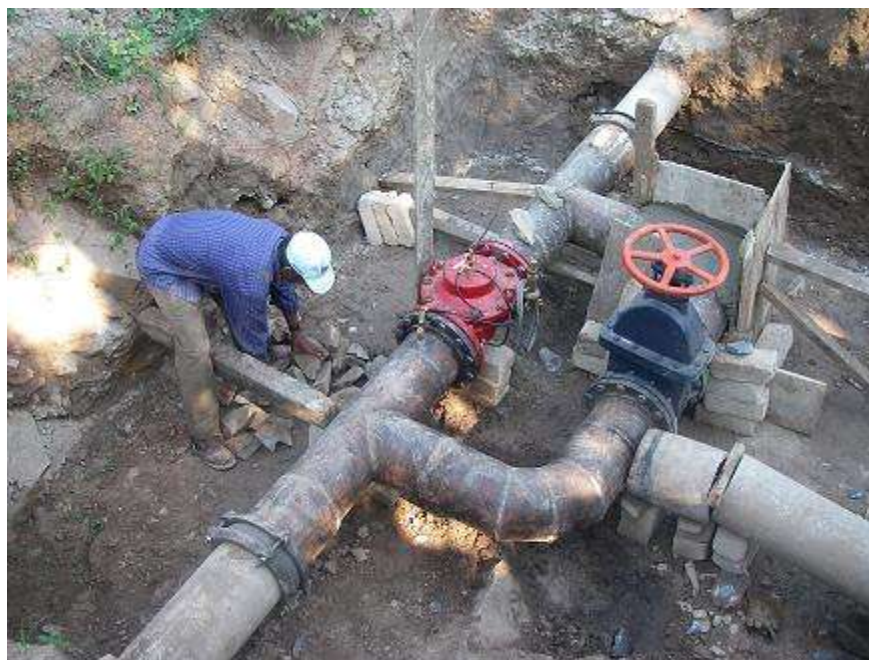
Figura 32. Uso de By-pass en la instalación de válvulas de control automático
