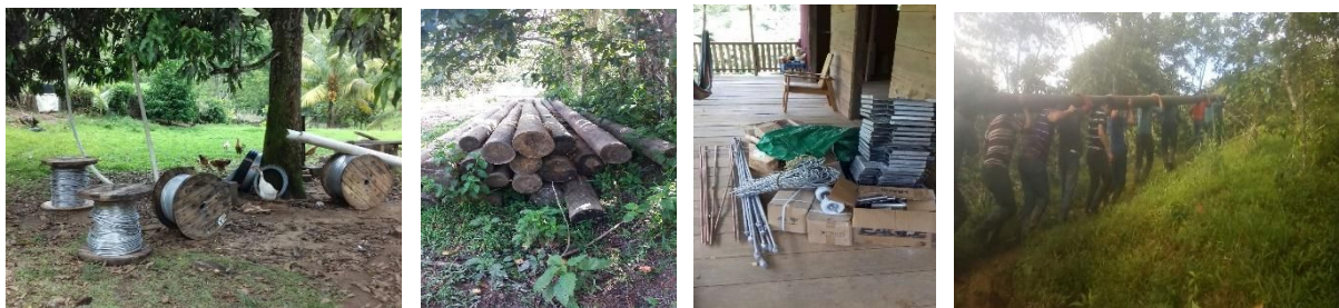
Fotografía 6: Construcción de extensión de Red
