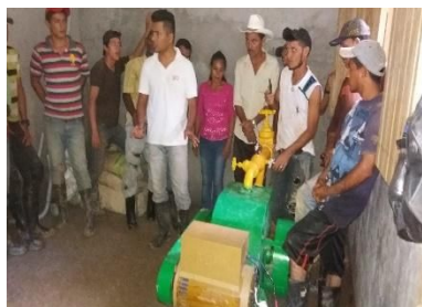
Fotografía 5: Instalación de Equipo Electromecánico y Capacitación
