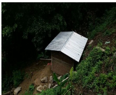
Fotografía 9: Casa de máquinas construidas (vista desde arriba)
