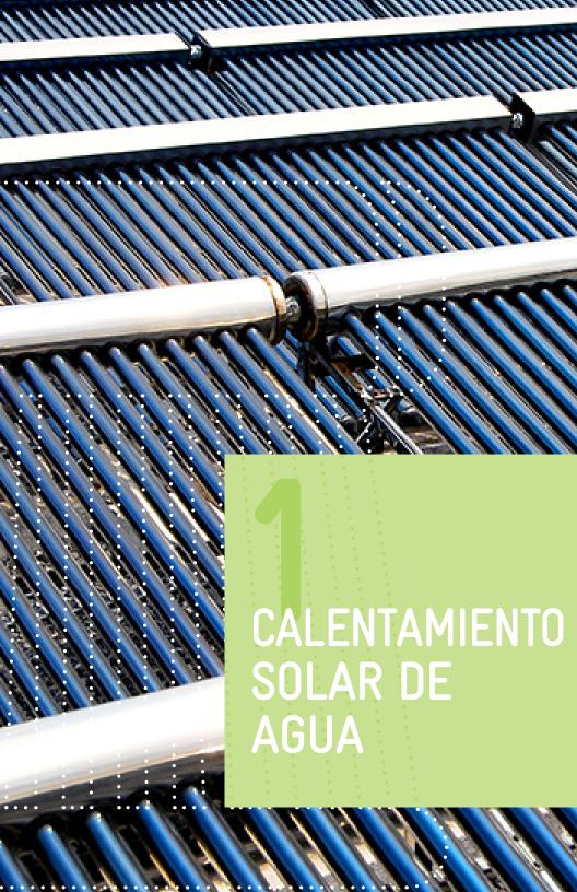
El calentamiento de agua es uno de los principales usos finales de la energía, se realiza usualmente mediante la quema de combustibles como gas LP, gas natural, leña y combustóleo y/o diésel. Por su parte, el calentamiento solar de agua (CSA) consiste en el aprovechamiento de la energía solar para realizar esta misma actividad pero a través de un proceso más económico y con impactos al medio ambiente prácticamente nulos.
