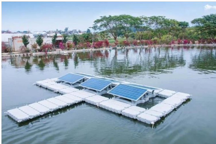
Sisteme për instalimin e paneleve në ujë (sisteme lundruese)
