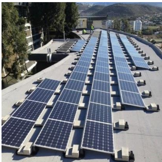
Ndërtim shtesë me balast për panele diellore për një çati të sheshtë
