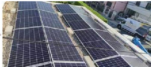
Instalimi i paneleve në një çati të sheshtë
