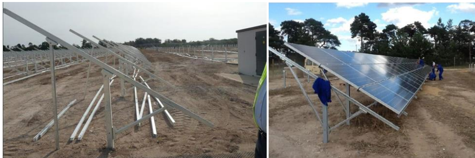
Instalimi i paneleve diellore në tokë
