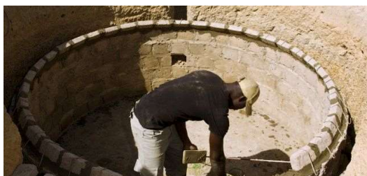
Figure 4-2 : Biodigesteur construit in situ au Bénin (modèle FASOBIO15)
