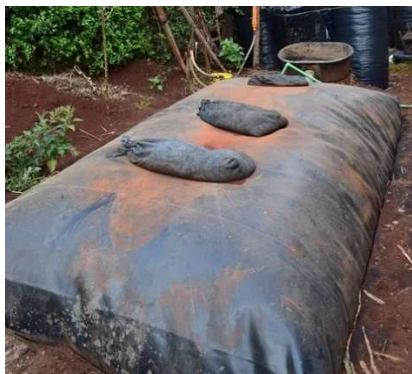
Figure 4-1 : Biodigesteur préfabriqué au Kenya
