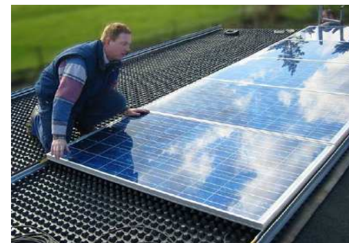
Exemples de pose sur sous-couche synthétique
