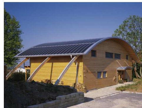
Membrane souple sur « bac alu »
