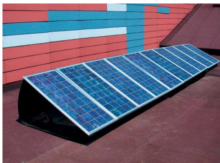
Exemple de pose sur bacs lestés
