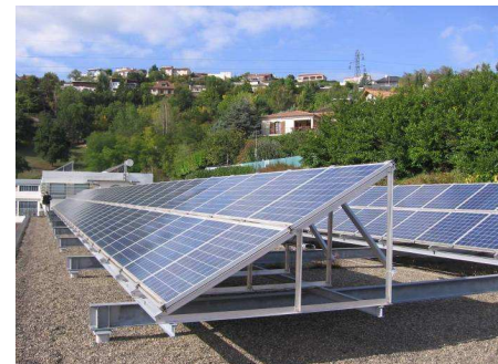
Exemple de pose sur châssis terrasse
