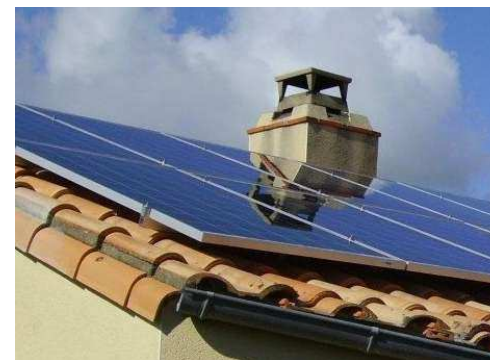
Exemple de superposition en toiture
