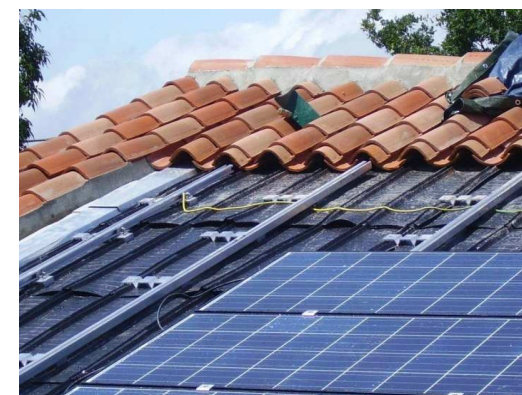
Exemples de pose sur sous-couche synthétique
