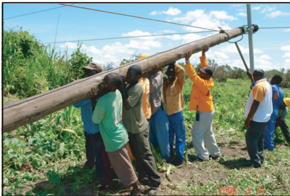
Reposição da rede eléctrica na Província de Nampula após o furacão Jókwe
