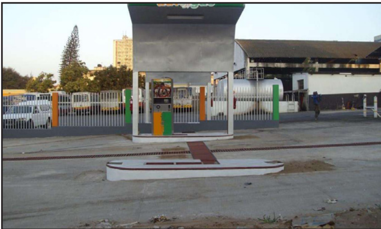
Postos de abastecimento de gás natural- Estação dos TPM.
