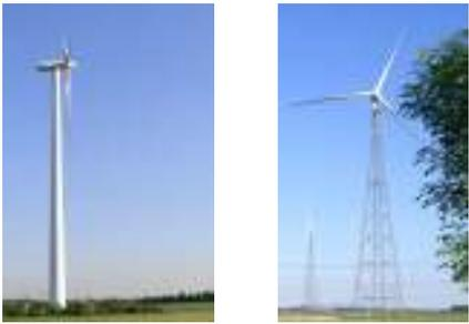
Stahl- oder Betonrohrtürme Gittermasten
