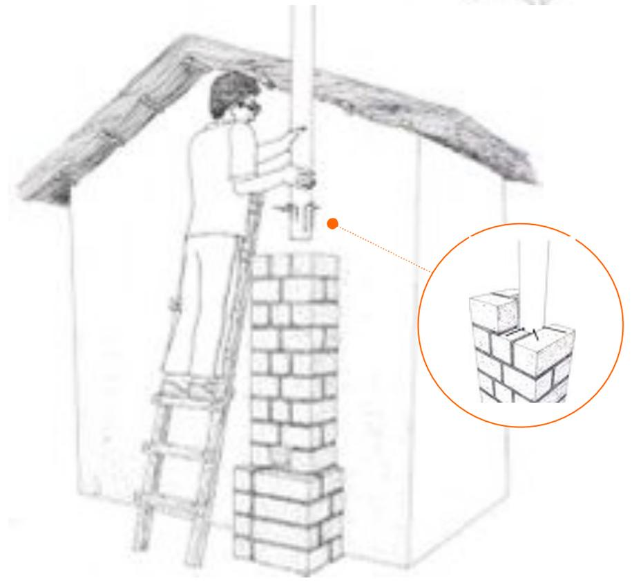
8. No olvidemos que la chimenea de metal se calienta mucho y puede quemar el techo. Si la chimenea de metal toca el techo y si tenemos un techo de paja o cualquier material que se pueda quemar hay que aislar muy bien el lugar por donde la chimenea de metal toca el techo con mortero de barro, tejas viejas o cualquier material que no se queme cuando esté en contacto con la chimenea.
