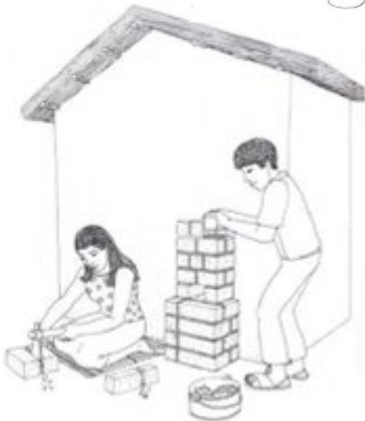
6. Vamos construyendo las hiladas de la chimenea alisando el interior con barro mejorado. Recordemos que mientras mas lisa quede la superficie interna es mejor. Podemos utilizar para la Cocina Malena, la botella Pet para alisar la superficie interna y para verificar el ancho del conducto.
