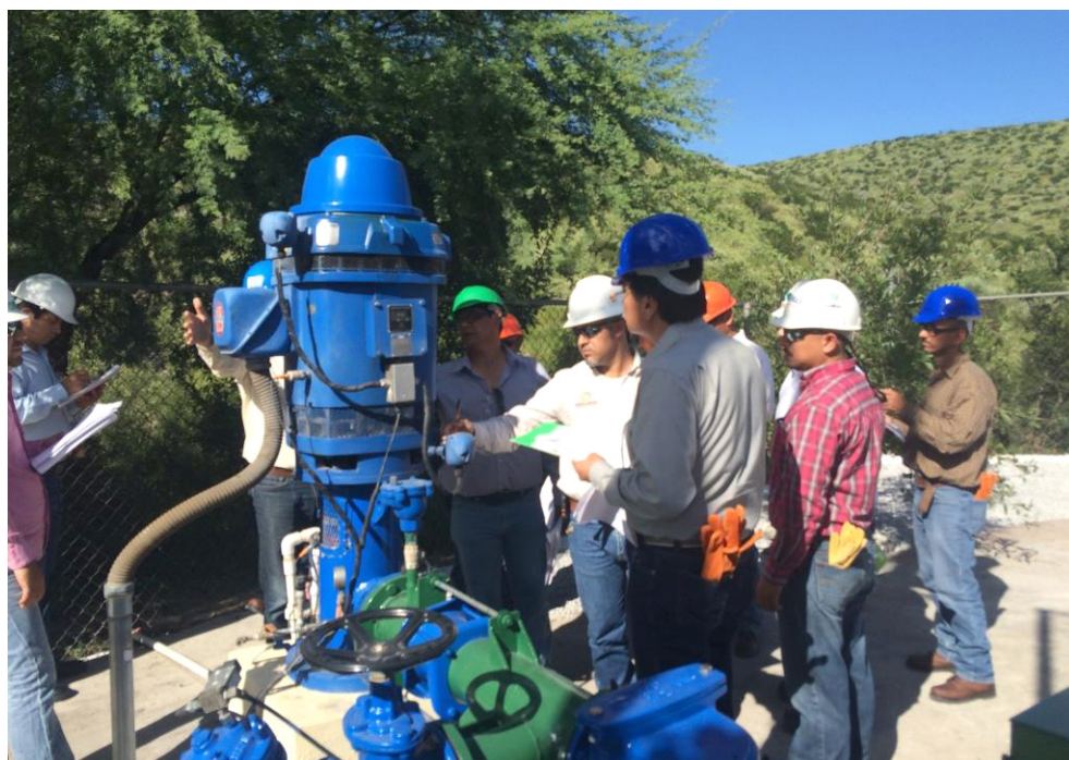
FIGURA 14. Capacitación EC0318: Mantenimiento Electromecánico de una Estación de Bombeo de Agua Potable
