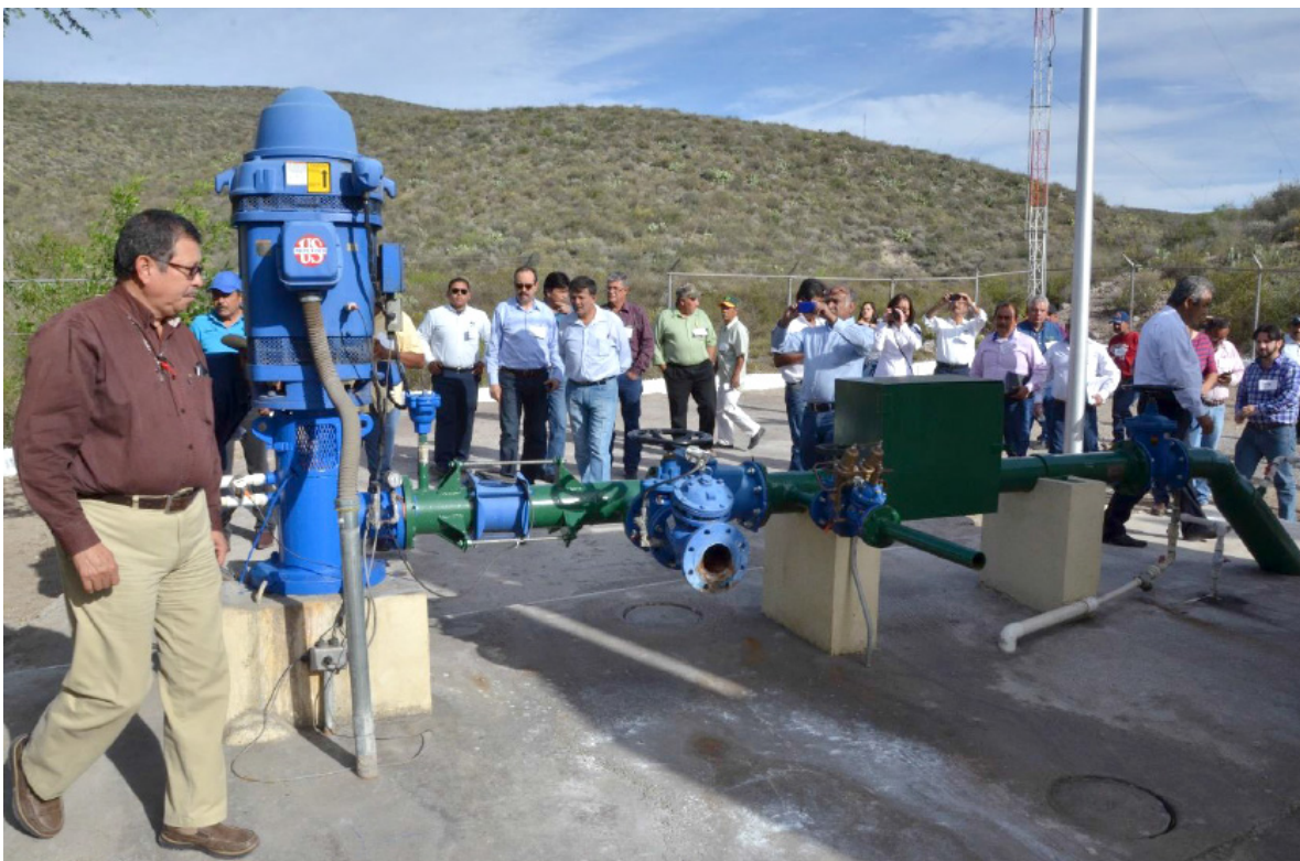
FIGURA 8. Primera visita de campo, SIMAS Monclova-Frontera
