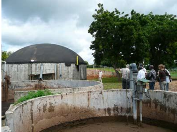
Abbildung 1: Fermenter und Gärrestelager der Biogasanlage in Kilifi; © GTZ/Kilifi Plantations Ltd
