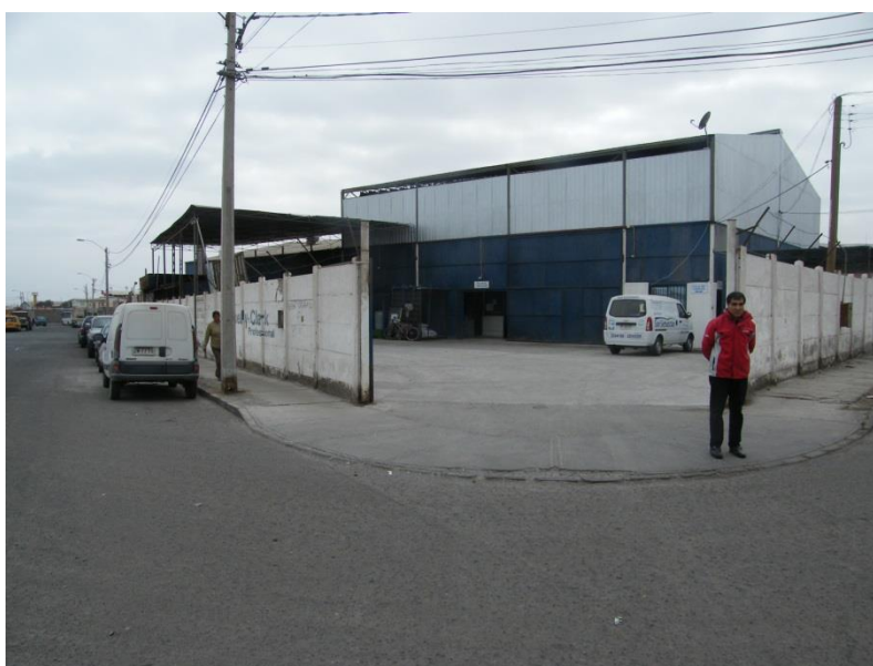
Ilustración 18: Lugar de instalación del generador solar
