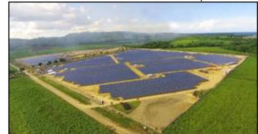
PV-Freifläche SaCaSol 22 MW p
