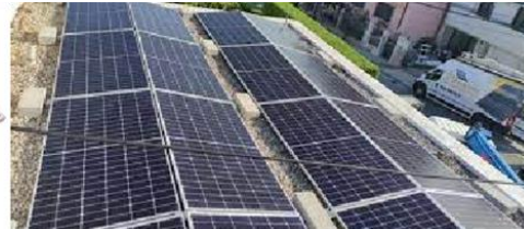
Инсталација на панели на рамен покрив
