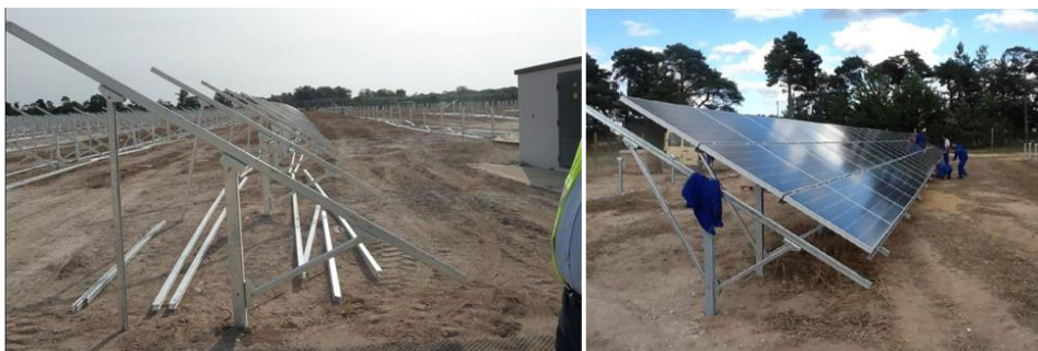
Инсталација на соларни панели на Земја
